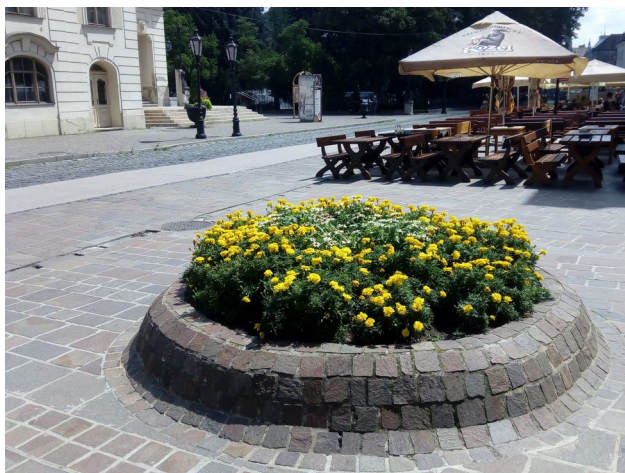
Hlavná ulica – ochranná bariéra nad plynovodom
