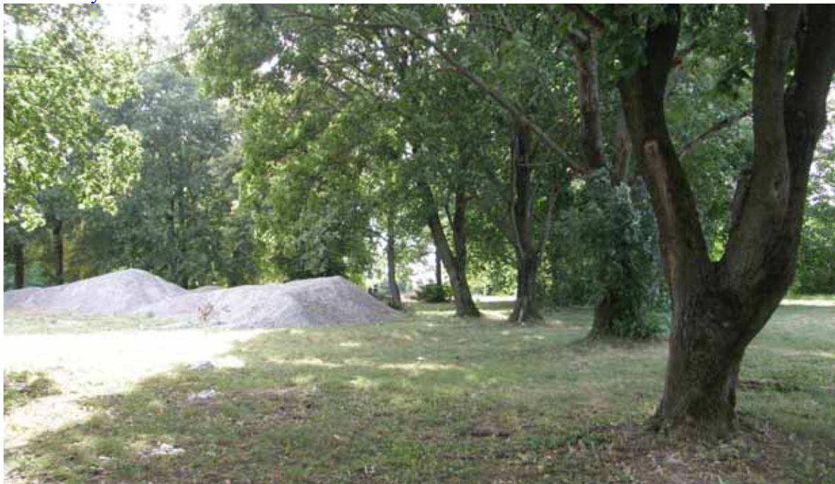
Obr.č.88 Nepripustné zavážanie parku stavebným odpadom a stavebným materiálom. Park nemôže byť "medziskládkou" materiálov.
