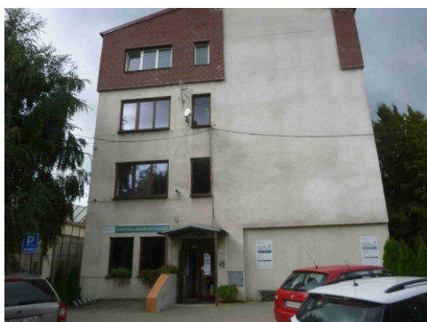
Obr.č.1 Pohľad východný
