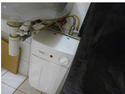
Obr.č.13 Prvky systému prípravy teplej vody
