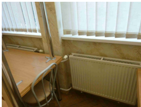
Obr.č.10 Prvky systému vykurovania
