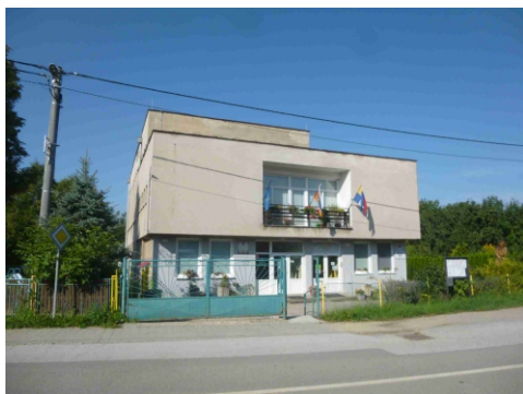
Obr.č.1 Pohľad východný
