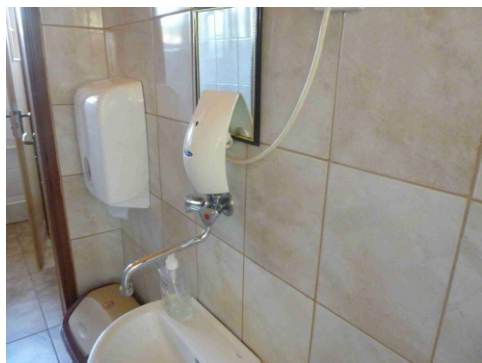
Obr.č.13 Prvky systému prípravy teplej vody
