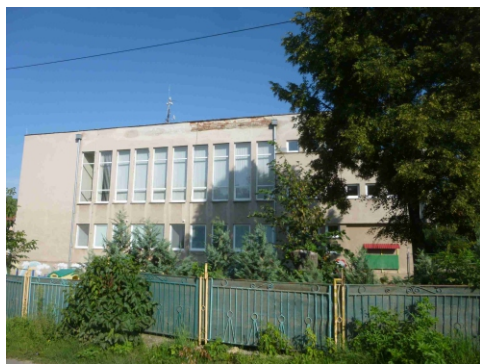
Obr.č.3 Pohľad južný
