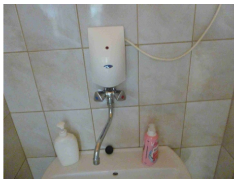
Obr.č.14 Prvky systému prípravy teplej vody
