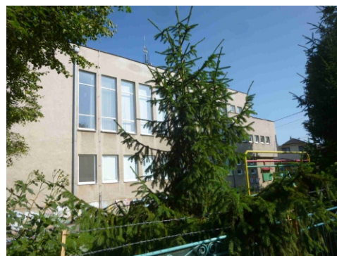
Obr.č.4 Pohľad severný
