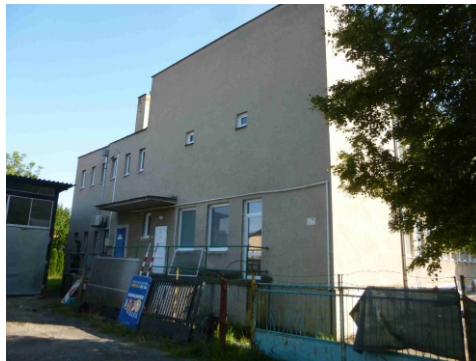
Obr.č.2 Pohľad západný
