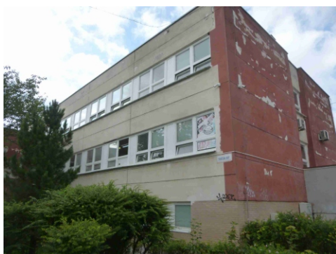
Obr.č.1 Pohľad východný
