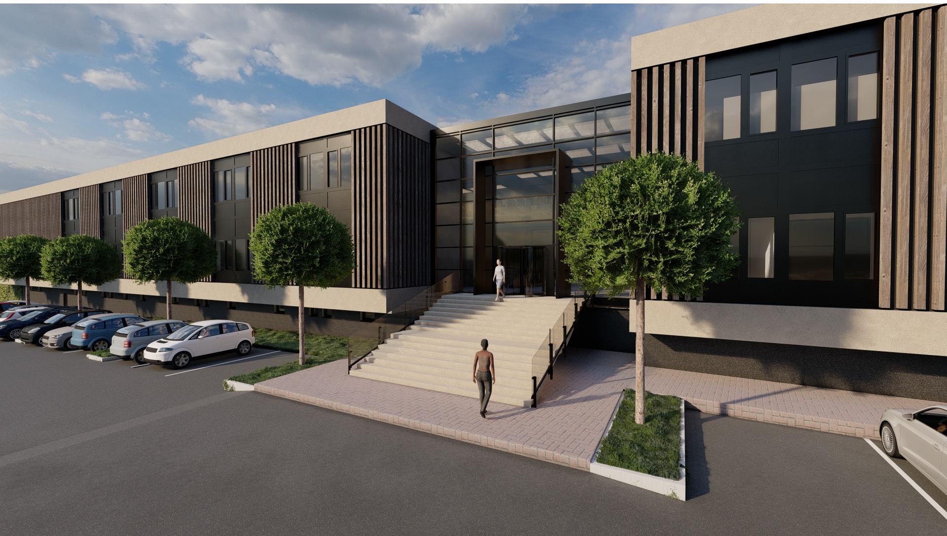
Pohľad východný hlavný vstup
