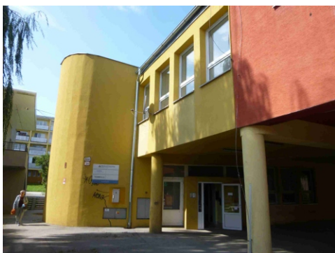
Obr.č.3 Pohľad južný
