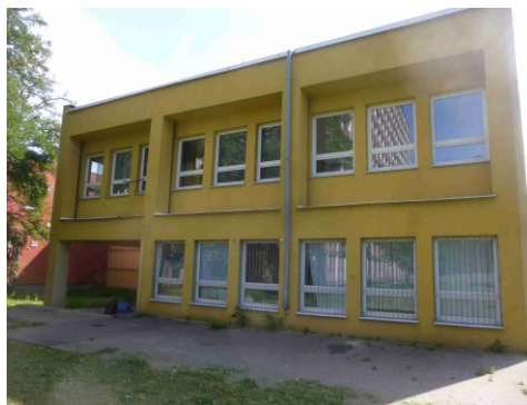
Obr.č.4 Pohľad severný
