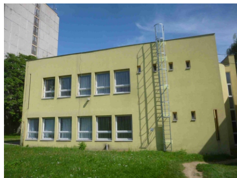
Obr.č.2 Pohľad západný
