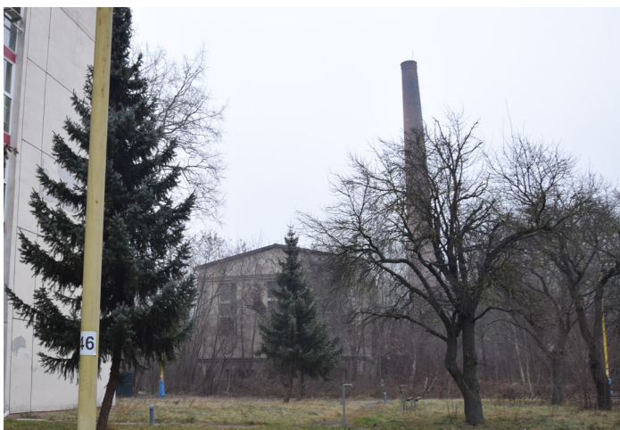
kasárne výhodná časť areálu TUKE obejkt kotolne s kominom
