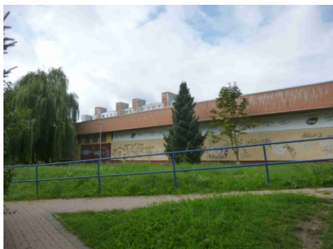
Obr.č.1 Pohľad východný
