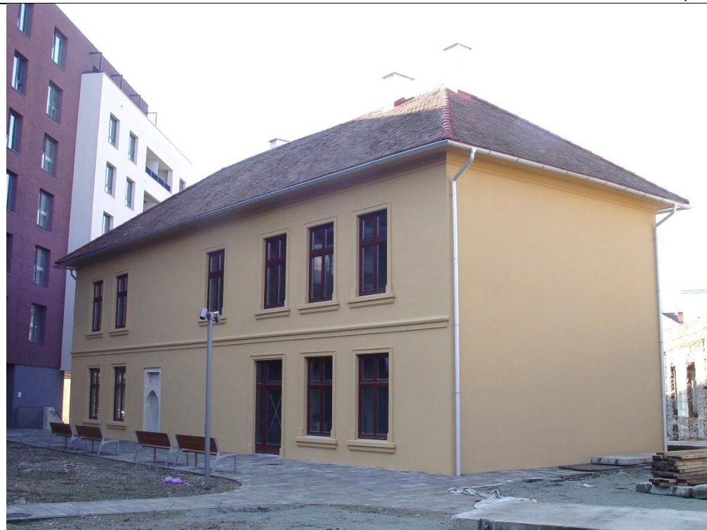
Vysoká hmota novostavby v dotyku s objektom laboratória, strata hist. siluety.
