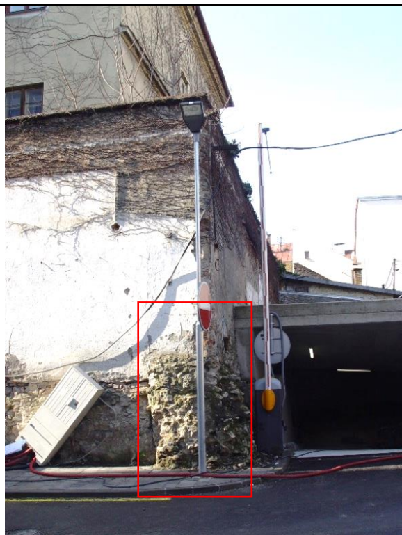
71 Pohľad na časť stredovekého hradbového múru, ktorý je súčasťou severného parcelačného múru kasární a pokračuje v suteréne parkoviska.
