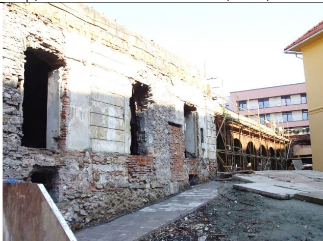
6.1 Objekt bastiónu (súčasť opevnenia)
