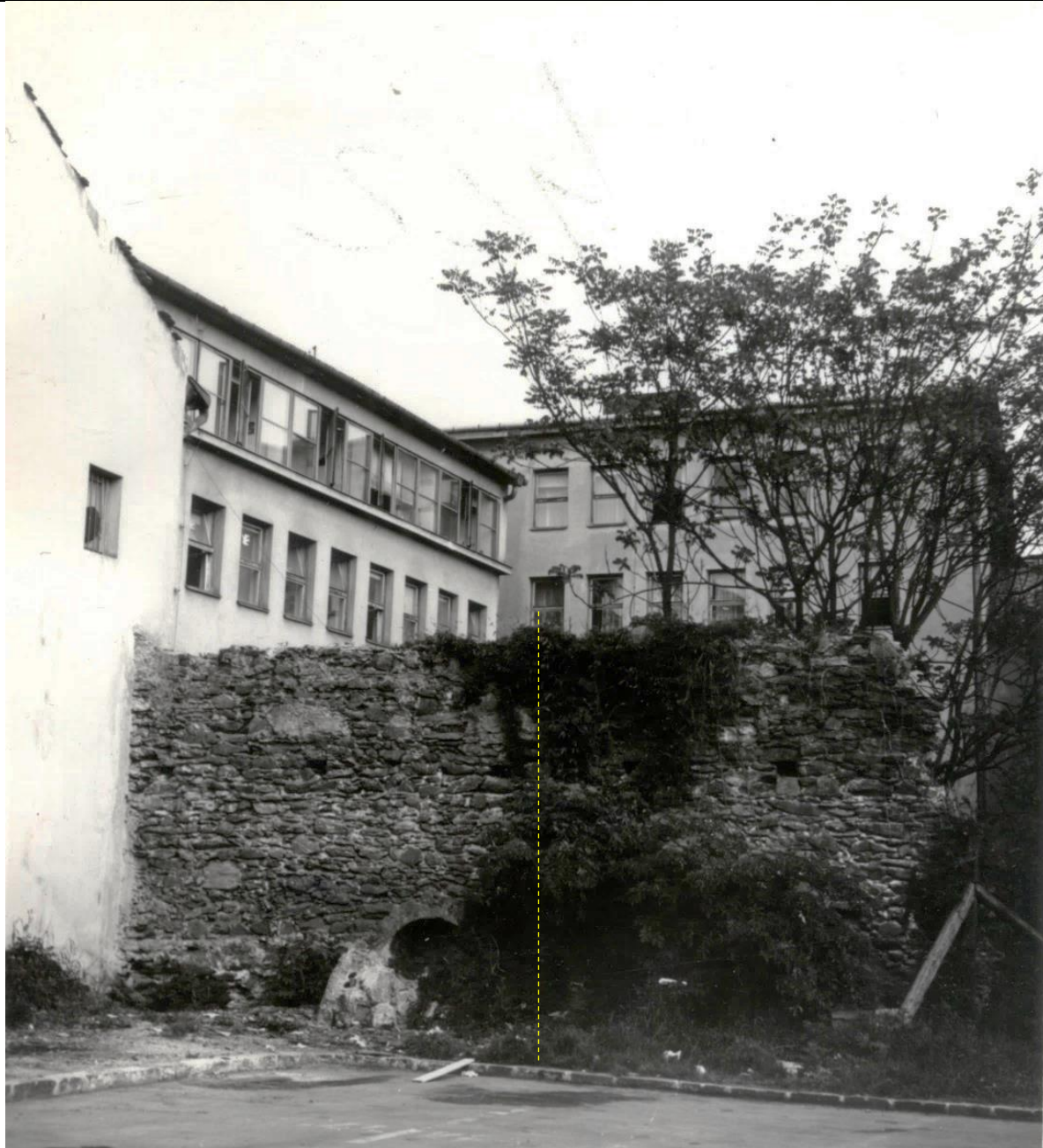
Hradbový múr (kurtina) bol súčasťou vonkajšieho pásu opevnenia, pokračuje severným smerom, kde je pravdepodobne súčasťou východného obvodového múru Kina Úsmev.
