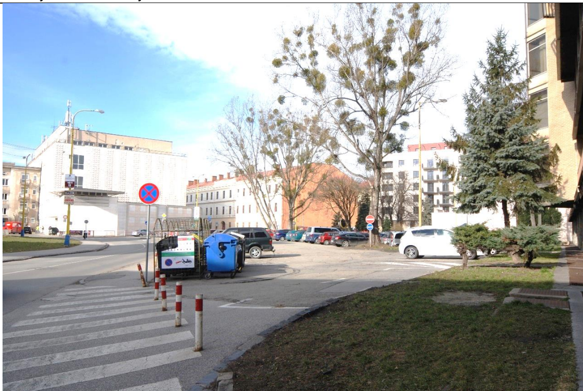
Dtto, porušený pôvodný princíp prejazdovej komunikácie osadením stĺpikov na vstupe na parkovisko, čím došlo k neprijateľnému komplikovanému dopravnému riešeniu na západnej strane plochy pred Priorom.
