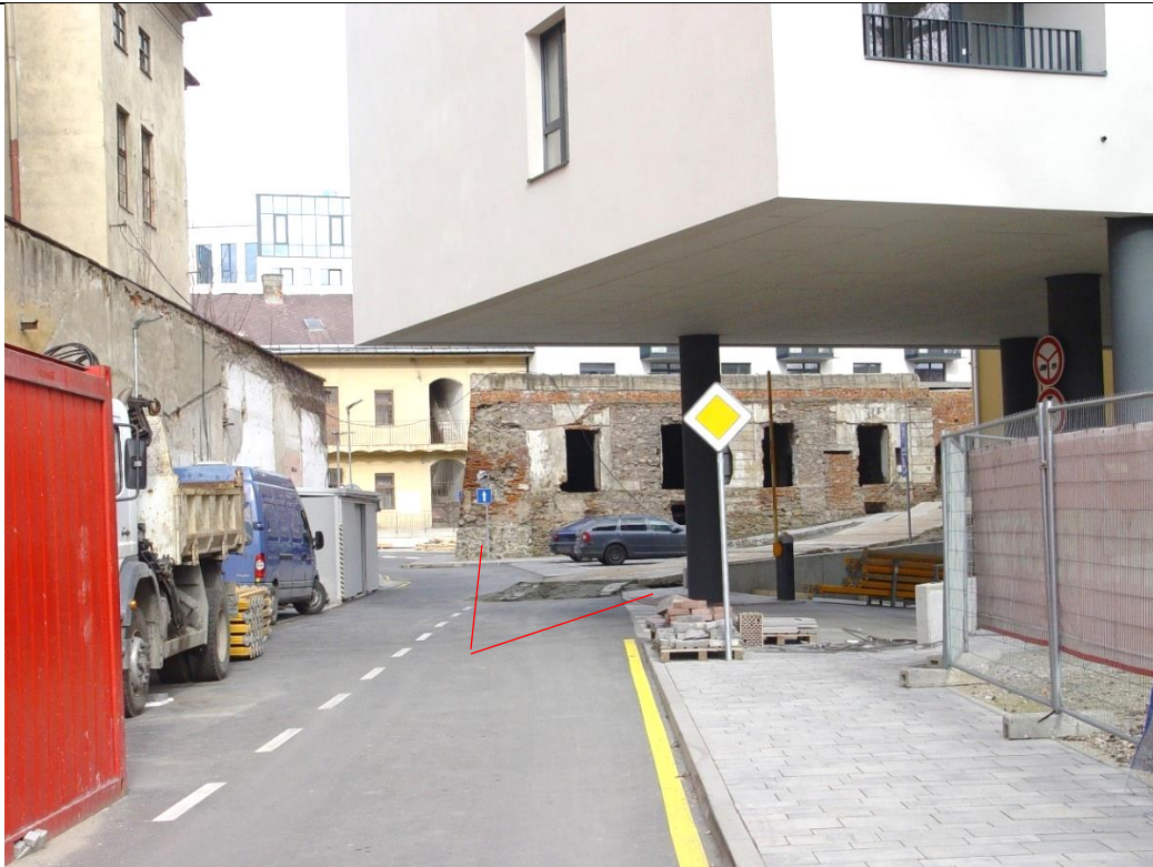
Pohľad na vnútroblokový priestor komplexu s fragmentami pôvodného opevnenia cez parter novostavby zasahujúcej nad prístupovú komunikáciu.
