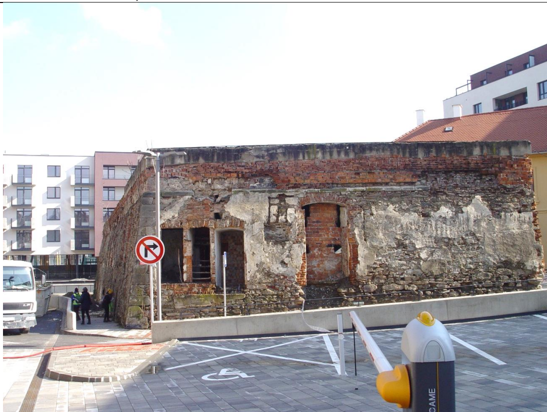
Pohľad na objekt bastiónu vo vnútri nádvorja obytnej novej zástavby s parkovacími miestami.
