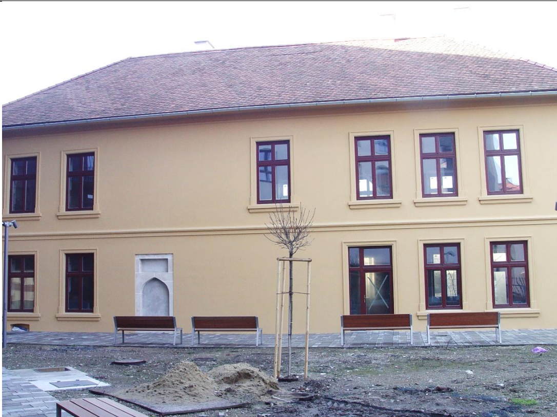
Čelná Jv fasáda objektu laboratória (prachárne), orientovaná do nádvorja, s prezentáciou staršieho kamenného portálu s nadsvetlíkom.
