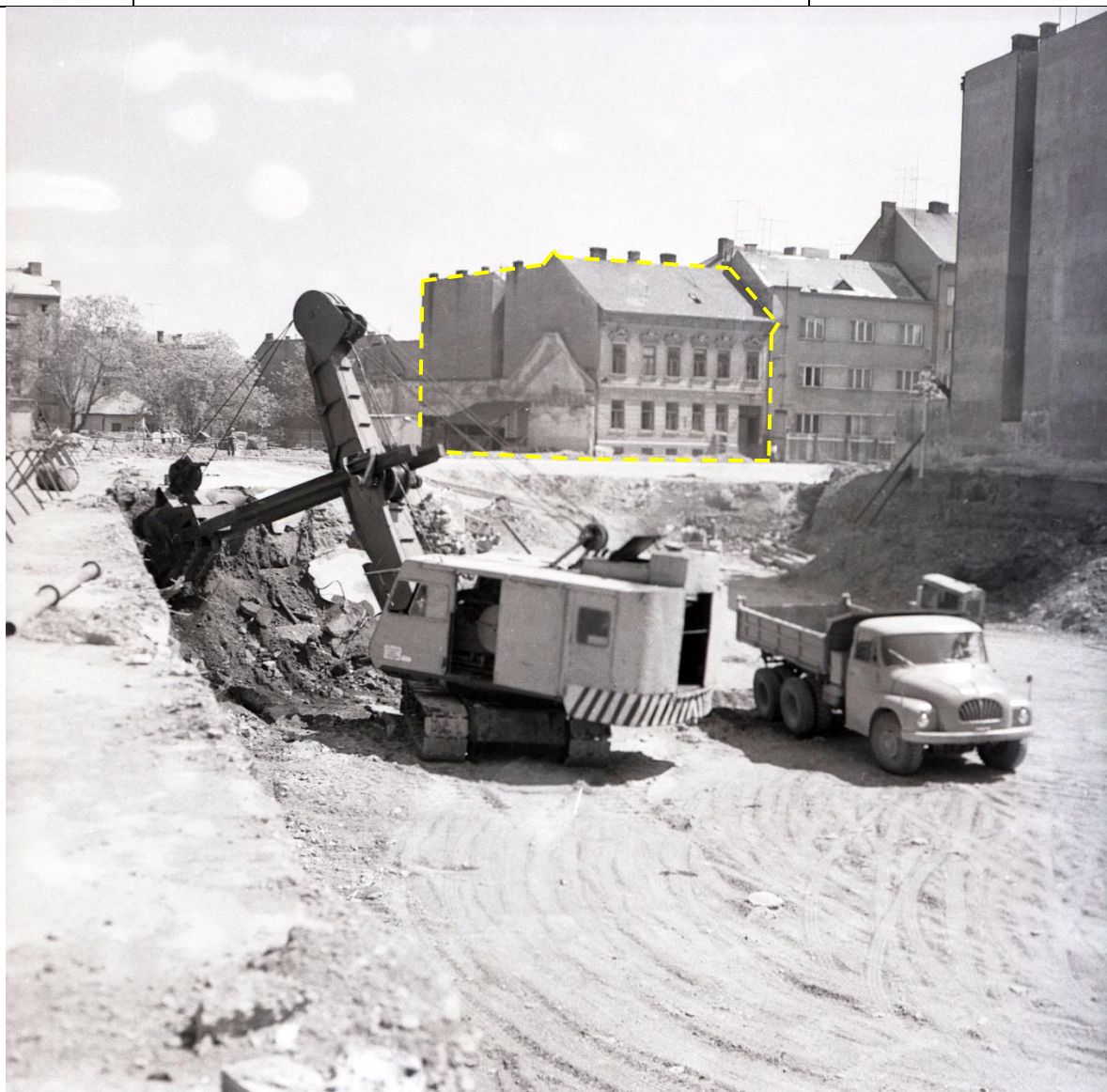
Žltou prerušovanou čiarou vyznačená asanovaná zástavba na Kováčskej ulici, dom č. 85.
