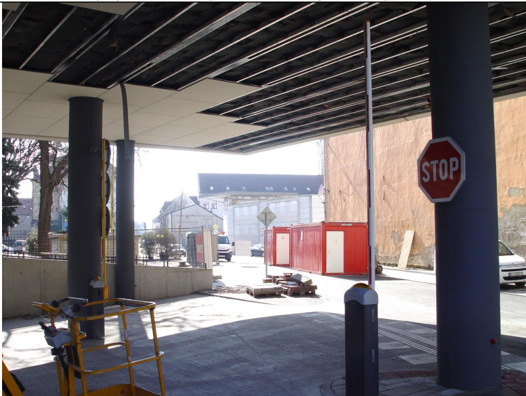
Pohľad z parteru novostavby bytového domu smerom na námestie a do Kováčskej ulice. Rampa vstupu do garáže domu.
