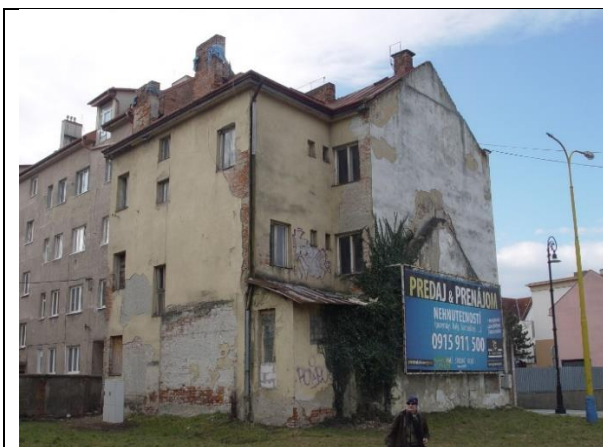
Pohľad na dvorovú časť objektu s prístavbou, narušené komínové telesá a štítovú stenu, na ktorej je ešte aj štítová stena prízemného asanovaného susedného objektu.
