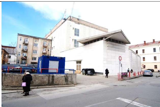
Pohľad na celok prístavby s vyloženou strechou.
