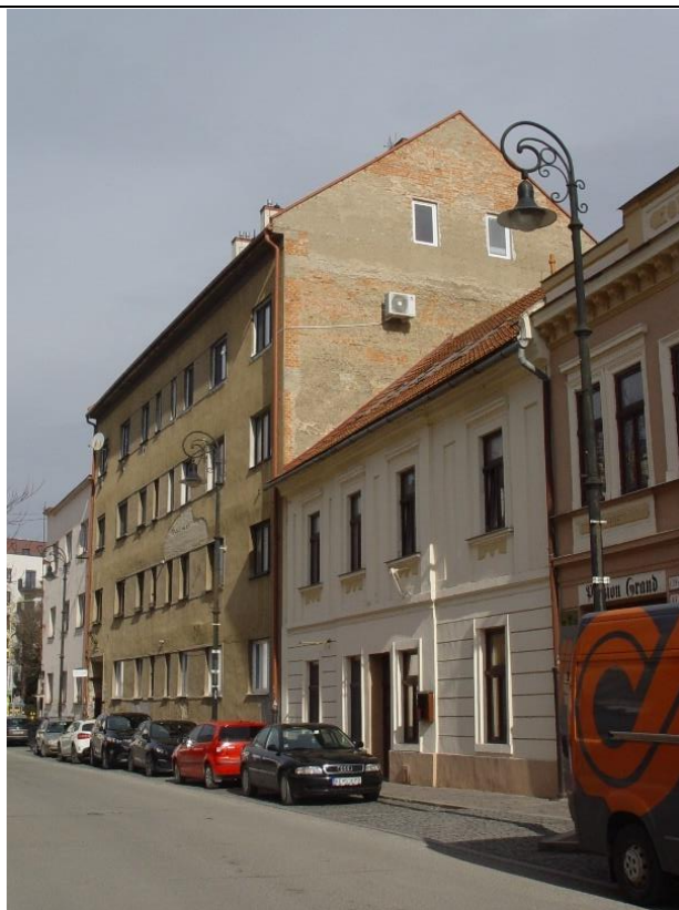
Celkový pohľad na uličnú fasádu so štítovým múrom, s oknami a klimatizačnou jednotkou.
