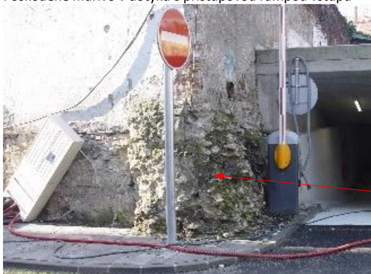
Poškodené murivo v dotyku s prístupovou rampou vstupu
