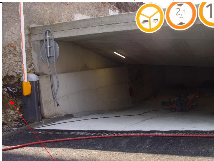
Poškodené murivo v dotyku s prístupovou rampou vstupu
