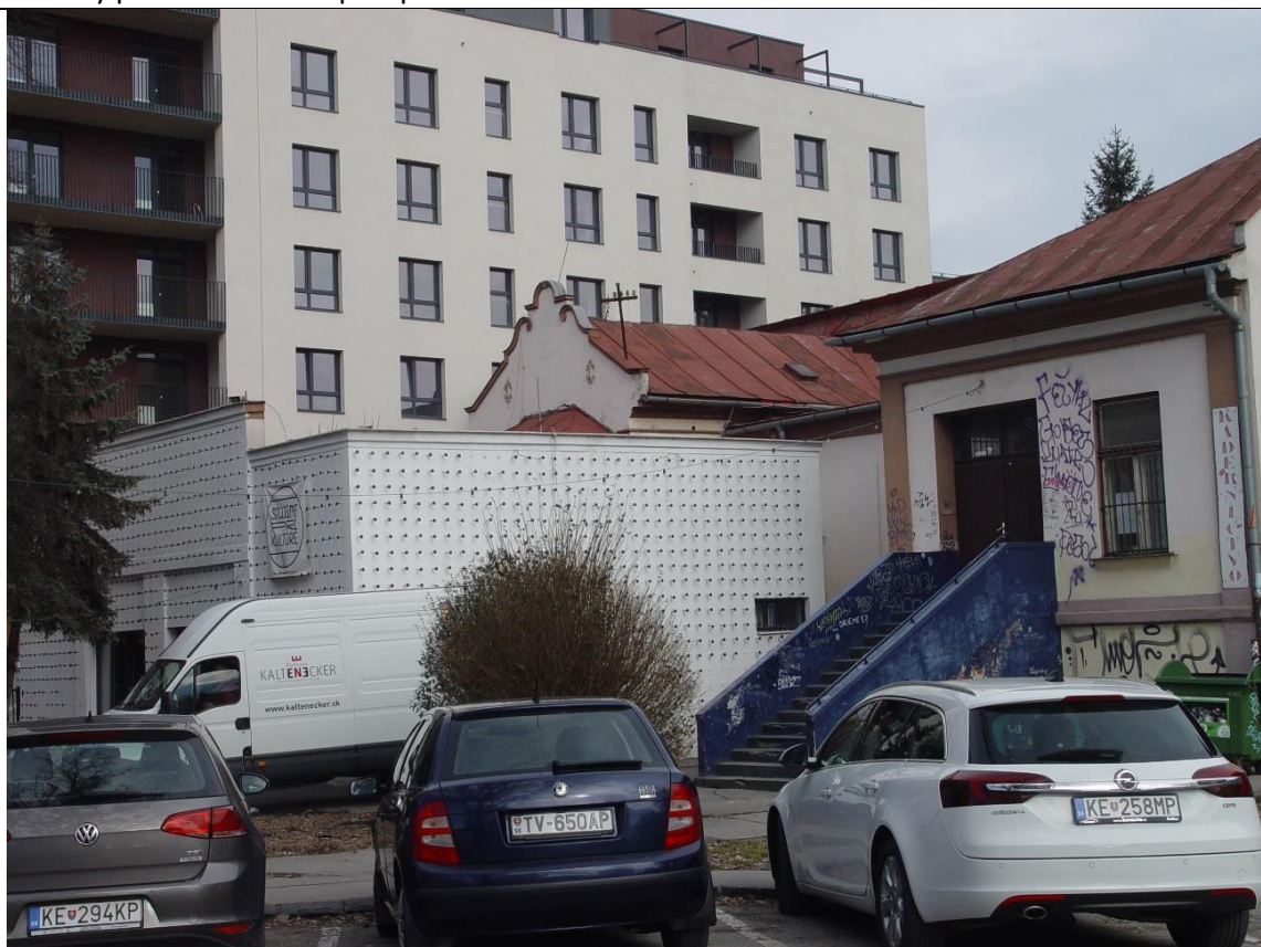
Detail priečelia s pôvodným secesným štítom a s mladšou prístavbou vestibulu
