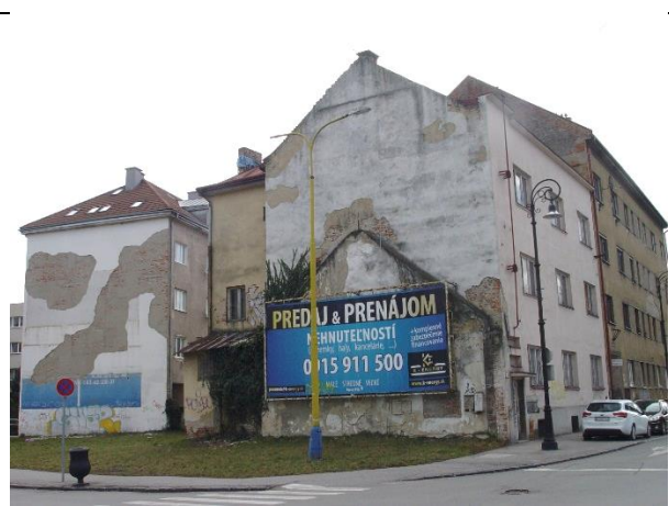
11 Pohľad na štítové steny domov: Kasárenské nám. č. 2 a Kováčska č. 71 v rámci rezervných plch ( R1.1 a R1.4, alt. R5 a R6 ) – plochy určené na napojenie nových stavieb, ktoré by ukončili blok.
