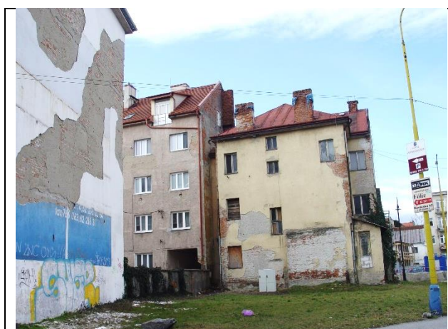
10 Detail odkrytých pôv. vnútorných dvorov medzi budovami na Kasárenskom nám. č. 2 a Kováčskej ul. č. 69 vľavo, a za domom č. 71 oproti ( Rezervná plocha č. R1.4 alt. 5 ) + obnažené dvorové fasády.
