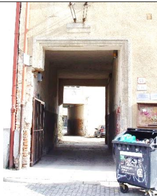
Pohľad na rozšírený vstup do prejazdu – do dvora s plastickým stvárnením ostenia profilovaným rámovaním.
