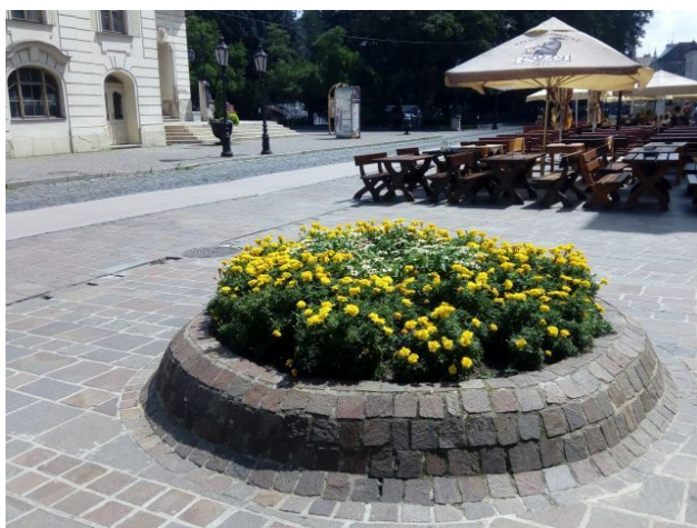
Hlavná ulica – ochranná bariéra nad plynovodom
