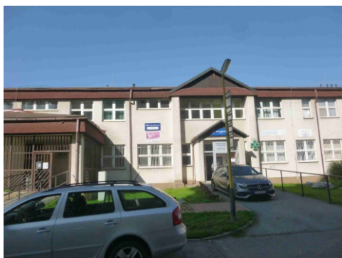
Obr.č.1 Pohľad východný
