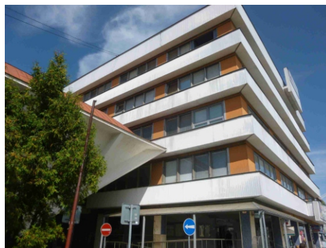
Obr.č.2 Pohľad západný
