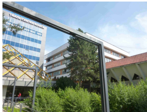
Obr.č.4 Pohľad severný
