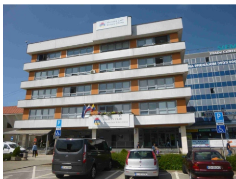
Obr.č.3 Pohľad južný
