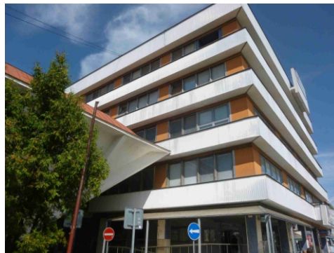
Obr.č.2 Pohľad západný
