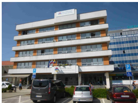
Obr.č.3 Pohľad južný
