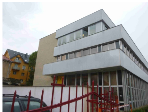
Obr.č.2 Pohľad západný
