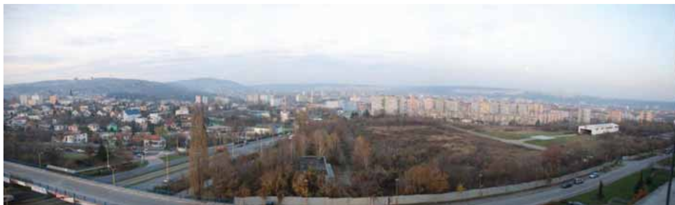
Pohľad na časť riešeného územia z objektu FNsP smer Košice SEVER
