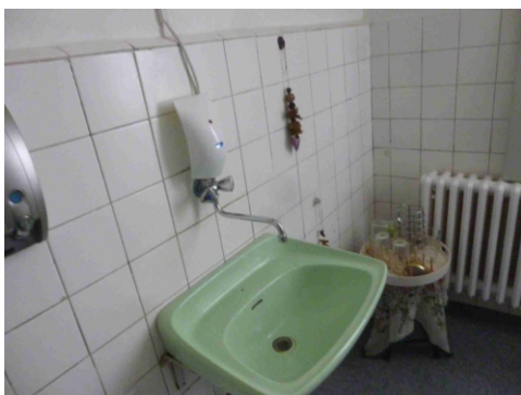
Obr.č.13 Prvky systému prípravy teplej vody
