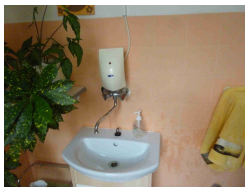
Obr.č.14 Prvky systému prípravy teplej vody
