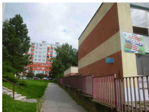
Obr.č.4 Pohľad západný
