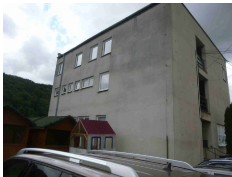
Obr.č.2 Pohľad západný
