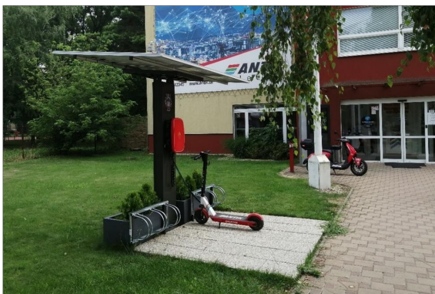
Obrázok 14 Fotovoltická nabíjacia stanica v areáli spoločnosti Antik
